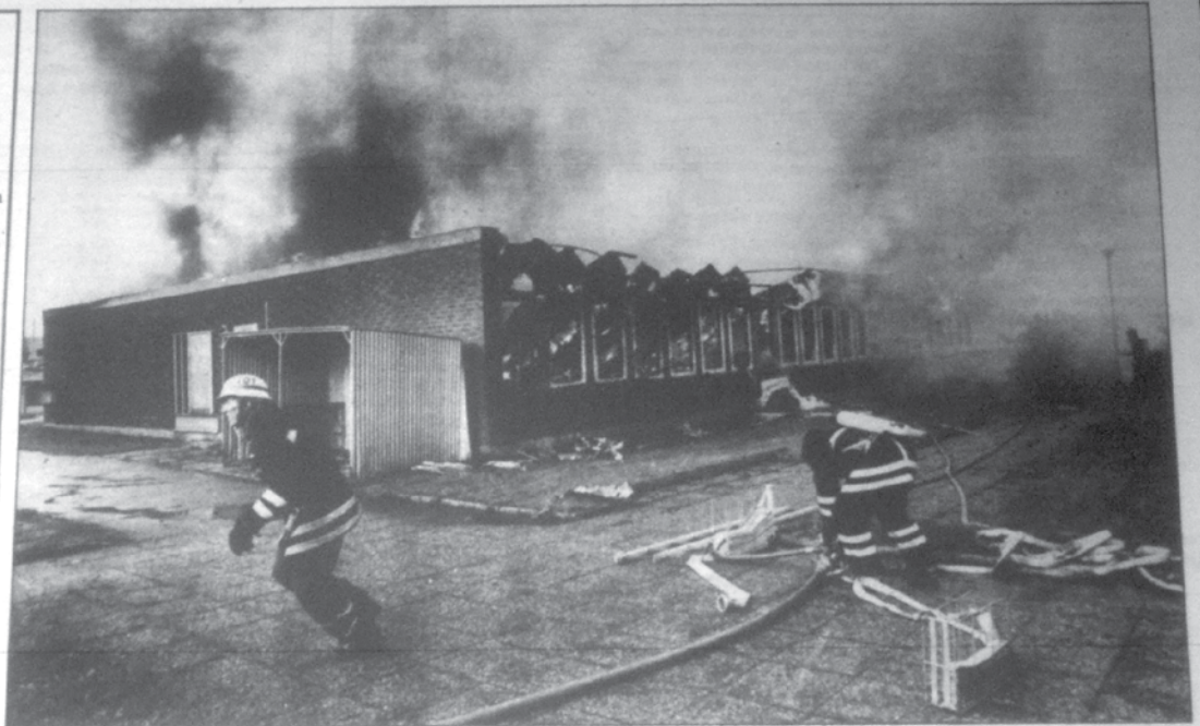
Den del av skolan där branden uppstod blev totalt urbränd. Taket rasade in och flera specialsalor blev till aska. (Foto: Anders Nilsson)
