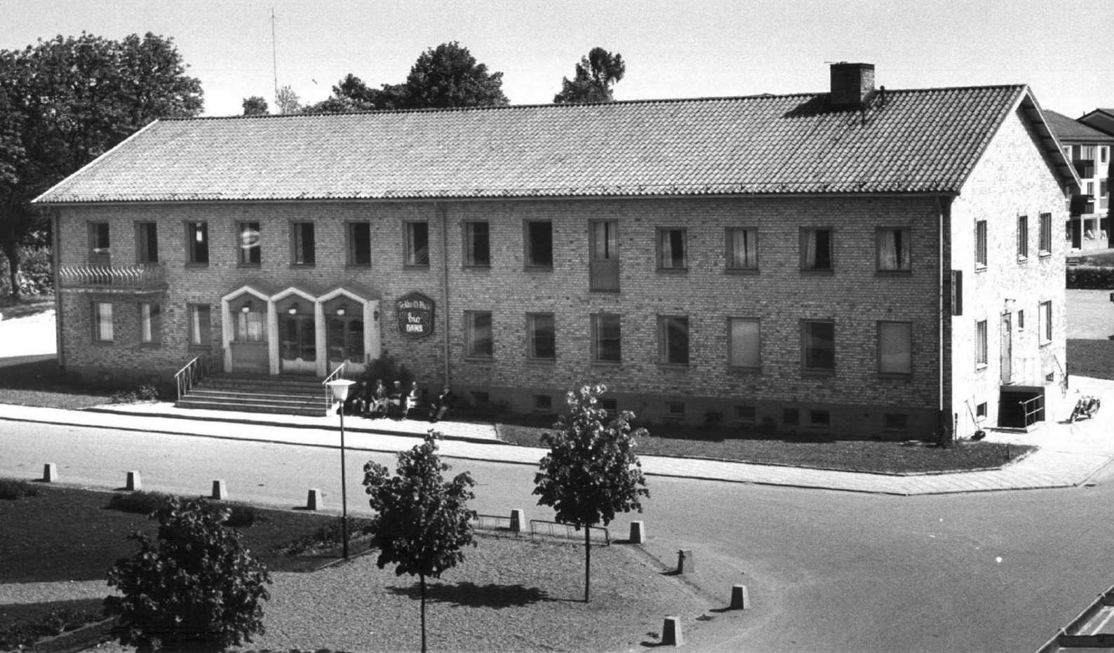
Folkets Hus som det såg ut då det var färdigställt. Bilden är emellertid tagen 1964.
