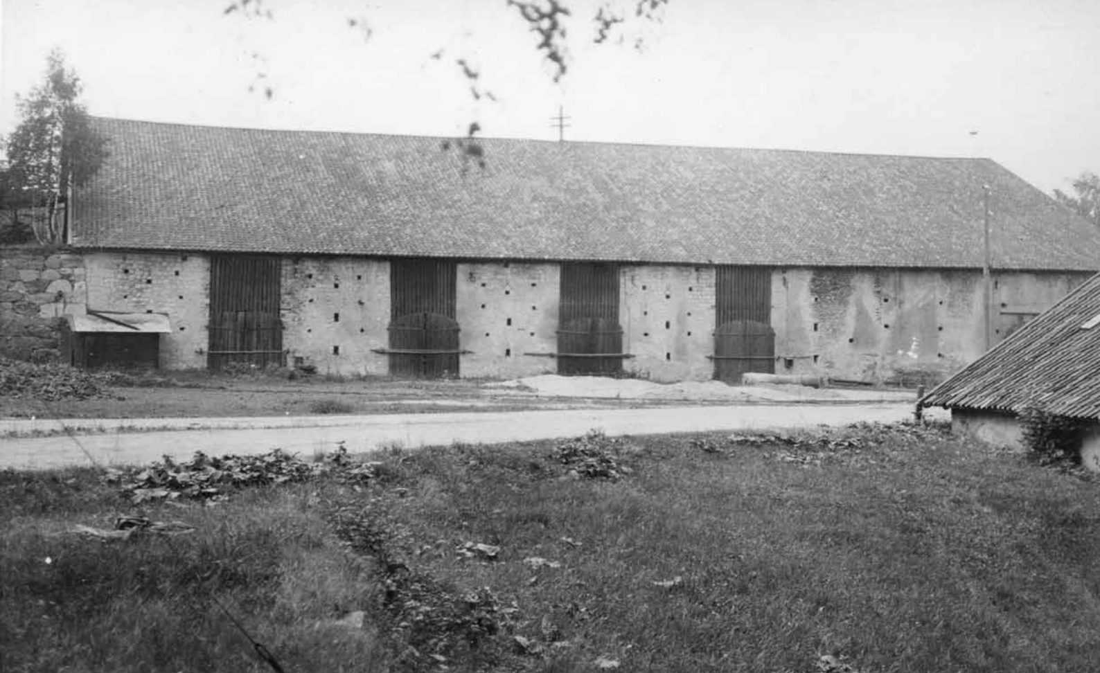
Bild 1. Det här var den information jag fann om kolhuset i Åkers styckebruk. Bilden finns på Tekniska museet som anger att kolhuset är byggt 1854 vilket visat sig vara fel. Rätt årtal för uppförandet av kolhuset av slagg har jag fått av Pehr Bengtsson. Foto Torsten Althin 1925
